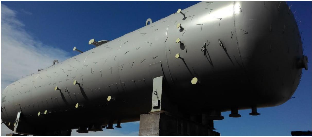
Монтаж отстойника-сепаратора пластовых вод на объекте.
