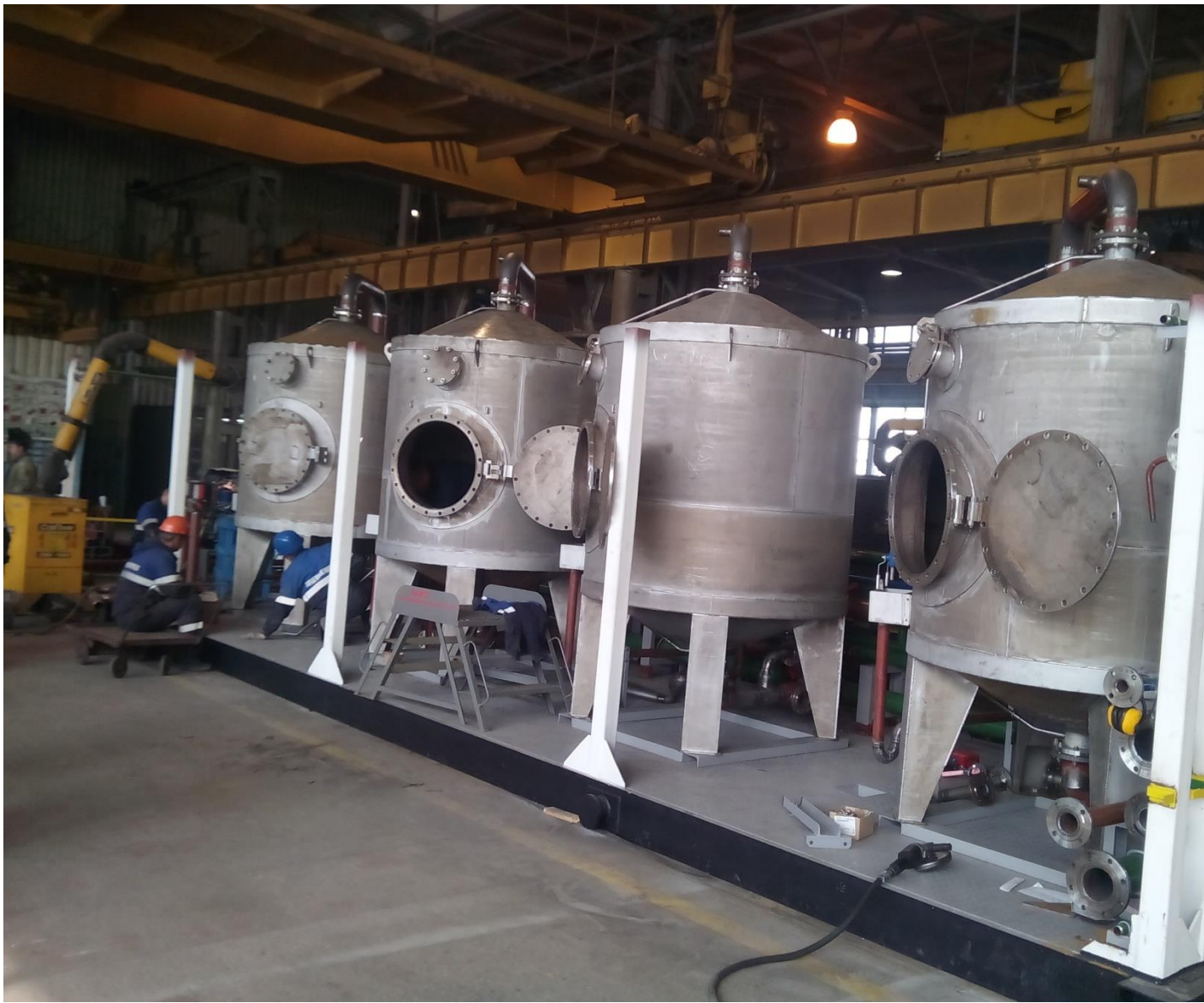
Сборка модуля фильтрации «МФСВ-700» на Тюменском экспериментальном заводе.
