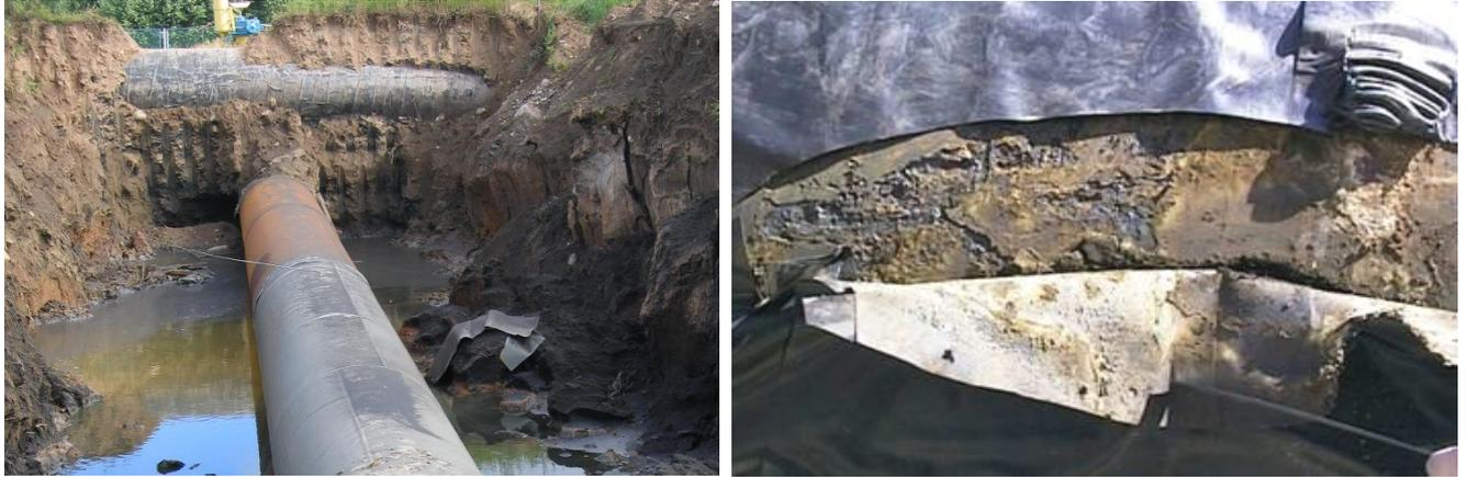
а – пересекающиеся трубопроводы; б – коррозионные повреждения металла трубопроводов под покрытием из полимерных лент
