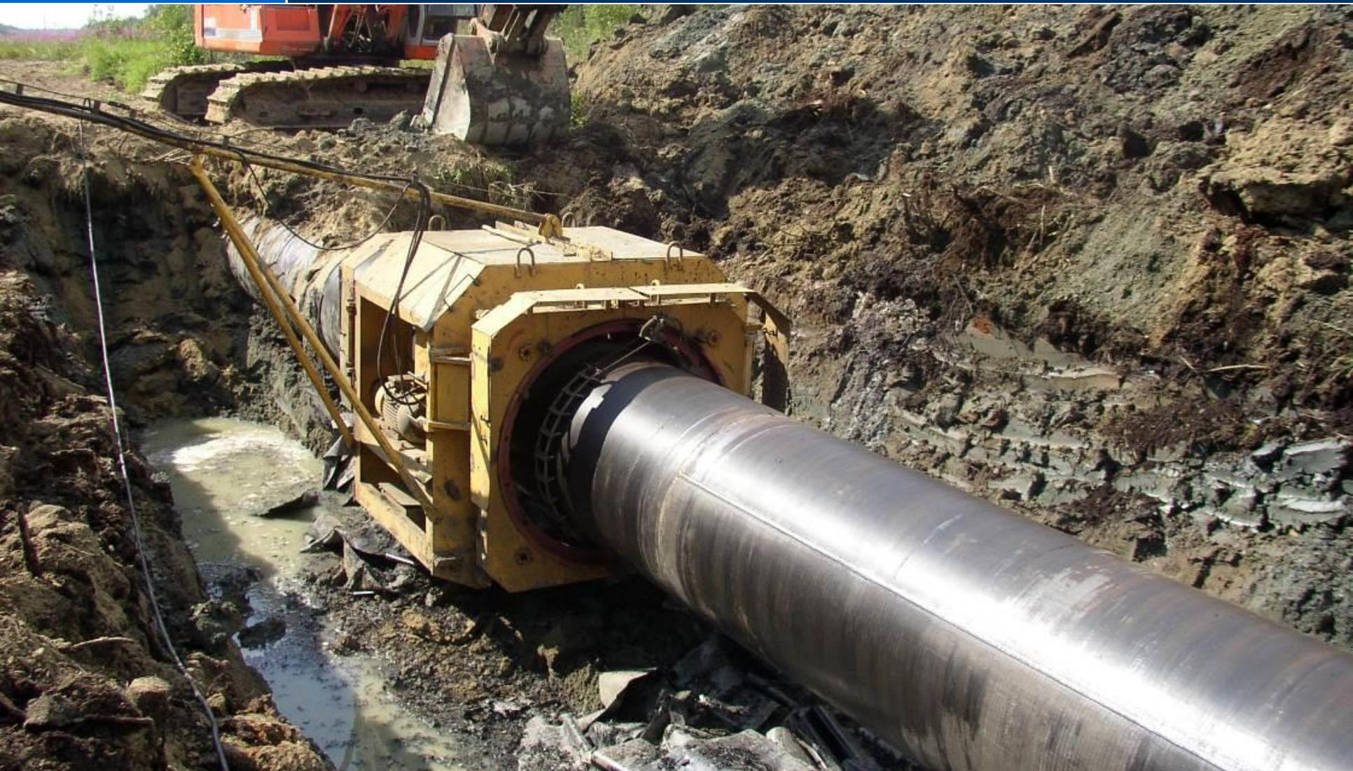
**В мае 2005 г. ЗАО «НПО «Спецнефтегаз» провело ВТД коррозионным снарядом-дефектоскопом ДМТБ-1400ВП-512 и стресс-коррозионным дефектоскопом ДМТП-1Б-1400ВП-960 на МГ Уренгой – Центр II диаметром 1420 мм между Заволжской и Сеченовской КС (2319,5–2420,5 км). Затем по результатам дефектоскопии велись работы по переизоляции участков газопровода.**
