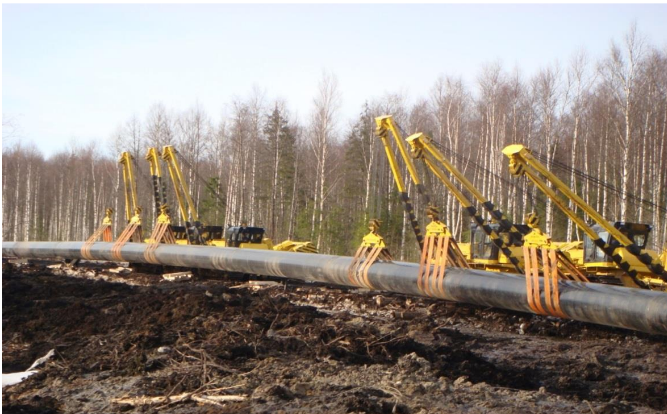
Рисунок 1 – Расстановка трубоукладчиков группами из-за особенностей расчетов, выполняемых по трем точкам подвеса.
