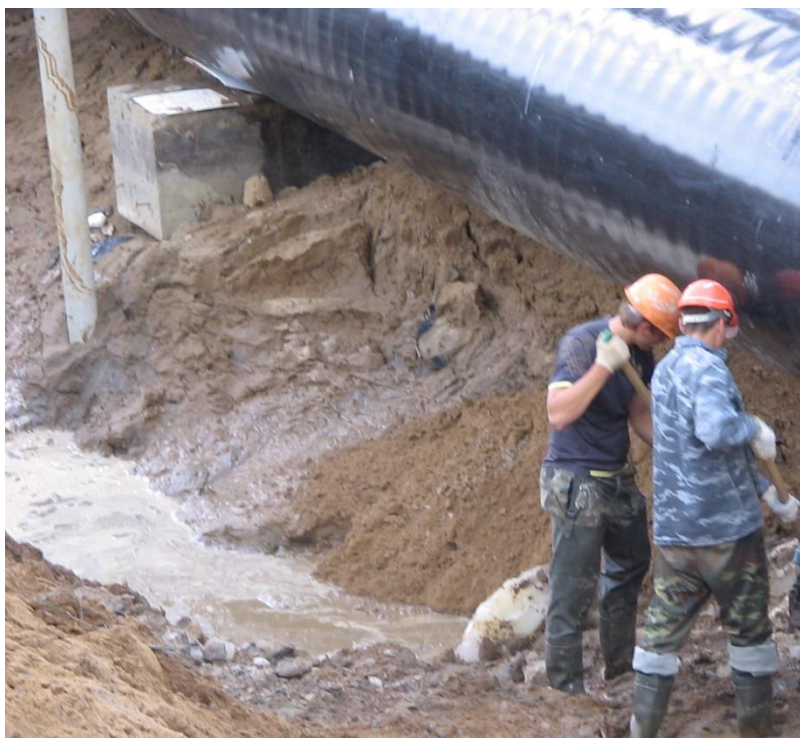
Рисунок 3 – Июнь, из-под вскрытого трубопровода, проложенного зимой, удаляют лед.
