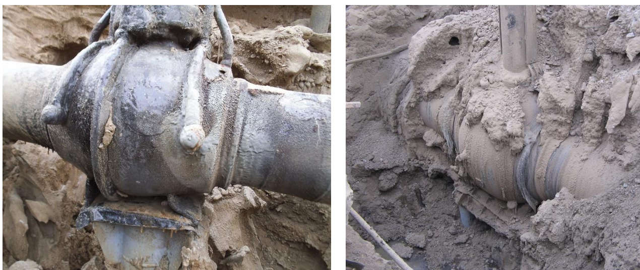
Рисунок 2 – Результаты бесконтрольной просадки трубопровода после оттаивания грунта.
