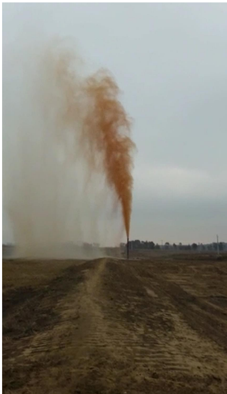
Рисунок 4 – Применение разработанного и внедренного при НТСС метода «динамической продувки» при очистке байпасной обвязки линейного кранового узла.
