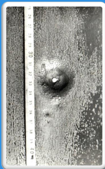
Сквозная язвенная коррозия. Шлейф 168x9 скв. 185д, УКПГ-2, сталь 20.
