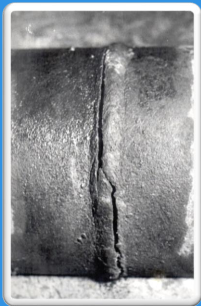
Трещина в сварном шве. Шлейф 168x12 скв. 167, УКПГ - 6, сталь 12Х1МФ.
