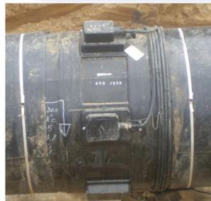
Измерение в месте установки интеллектуальной вставки; с потерей точности – до 10 м.
