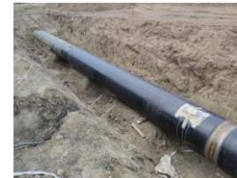
Трубное изделие с интегрированными регистрирующими волоконно-оптическими датчиками, расположенными в трех сечениях на трёх образующих трубы ( $0^\circ - 120^\circ - 240^\circ$ ) и датчиками температуры
