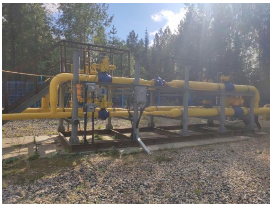
Рисунок 3.5 – Временный узел редуцирования: а) монтаж; б) опытно-промышленная эксплуатация
