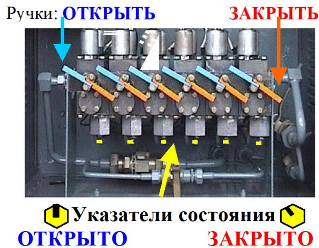
Рисунок 4.13 – Система ручного управления ДКД [59]
