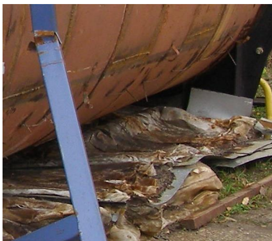
Рисунок 1.22 – Характерный вид теплоизоляционного покрытия корпуса подогревателя с длительным сроком эксплуатации (ПТПГ-30)
