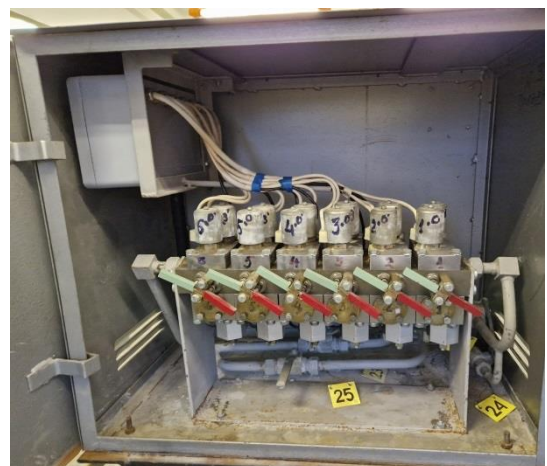
Рисунок 4.5 – Автоматизированная система управления ДКД (ГРС «Сосногорск»):
