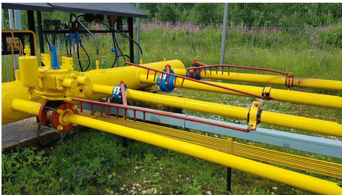
Рисунок 4.1 – Схема исполнения (а) и общий вид (б) системы регулирования давления и расхода с группой запирающих устройств
