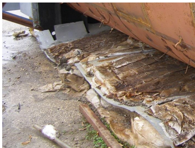
Рисунок 1.22 – Характерный вид теплоизоляционного покрытия корпуса подогревателя с длительным сроком эксплуатации (ПТПГ-30)
