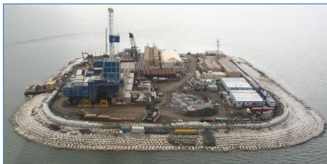
Рисунок 1.3 – Искусственный остров с защищенными откосами
