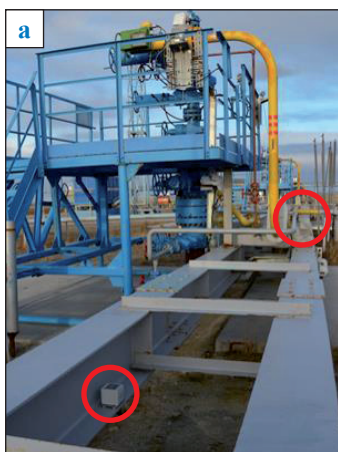
Инклинометрические датчики: контроль перемещений фундаментов трубопроводных обвязок (2 шт. на ГС)
