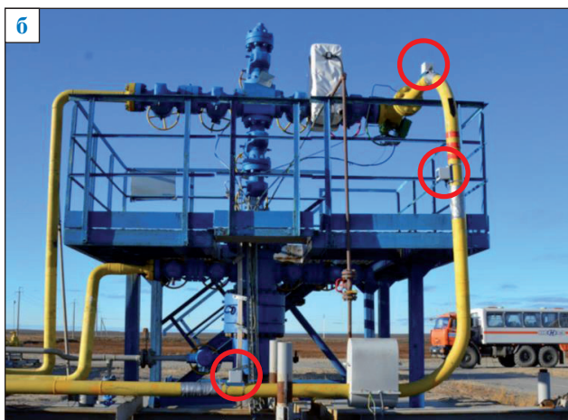
Рис. 5. Расположение элементов блока параметрического контроля на тестовых объектах
