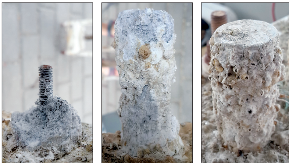
Рис. 2. Состояние протекторов на элементах конструкции комплекса после натуральных испытаний
