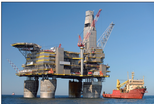
Рис. 11. Платформа с опорной частью гравитационного типа «Лунская-А» (ЛУН-А) проекта «Сахалин-2». Источник: https://www.gazprom.ru/projects/sakhalin2
