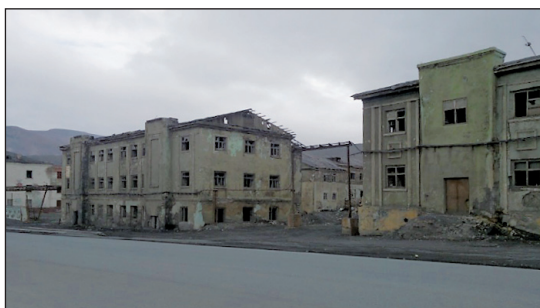
Рис. 1. Норильск, старый город. Основа для фундаментов – скальный грунт, фактор мерзлоты при проектировании не учитывается
