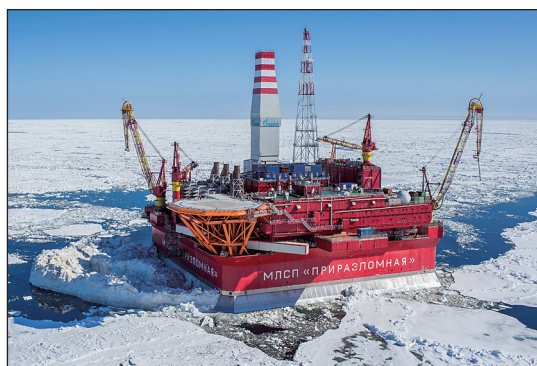
Рис. 10. Стационарная платформа «Приразломная» с кессонным гравитационным основанием
