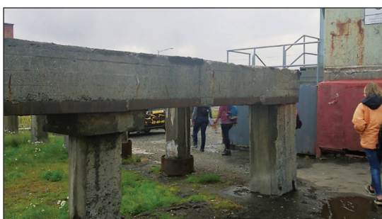
Рис. 2. Норильск. Фундамент свайного типа на многолетнемерзлых грунтах
