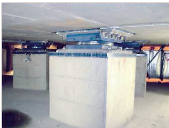
Рис. 11. Установленная скользящая маятниковая опора ИР СПГ, Греция
