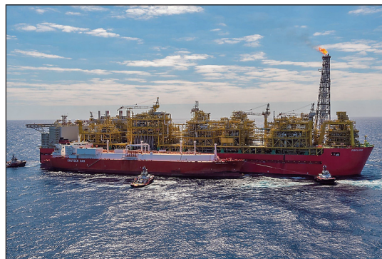
Рис. 12. Технологическое судно LNG FPSO Prelude компании Shell. Источник: Эволюция технических решений для Штокмановского ГКМ и современный взгляд на его обустройство // Neftegaz.ru. – 20.04.2021. – https://magazine.neftgaz.ru/articles/shelf/677243-evolyutsiya-tekhnicheskikh-resheniy-dlya-shtokmanovskogo-gkm-i-sovremenny-vzglyad-na-ego-obustroyst
