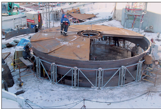
Рис. 3. 8-й день монтажа РВС
