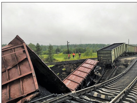
Рис. 1. Последствия аварии на участке Кожва – Сосногорск [3]
