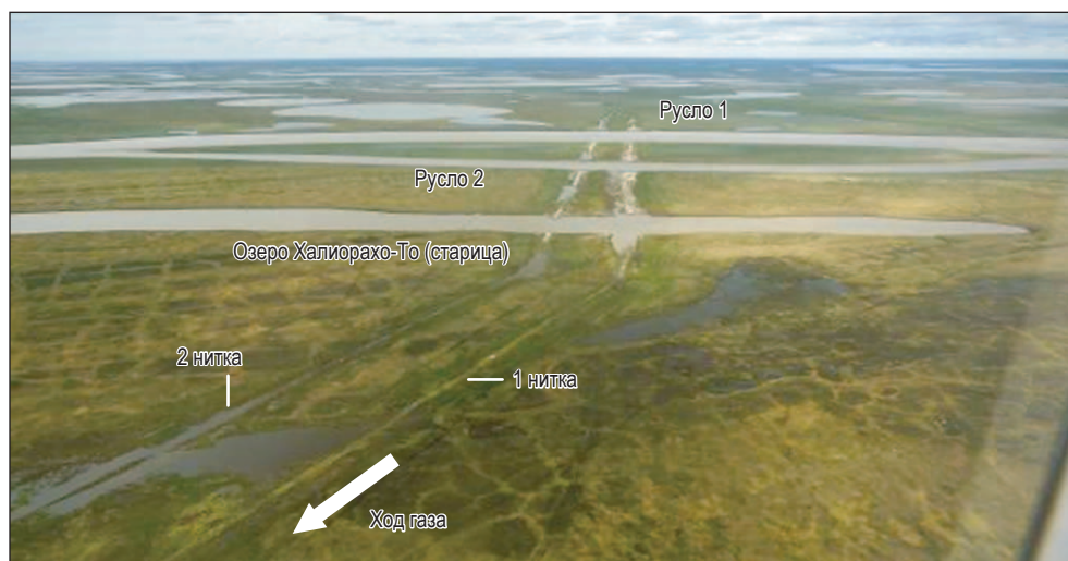
Рис. 1. Общий вид перехода газопровода Бованенково – Ухта через р. Морды-Яха
