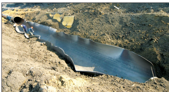
Рис. 9. Испытания высокопрочных труб
