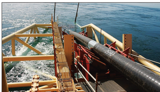
Рис. 11. Укладка обетонированных труб газопровода Джубга – Лазаревское – Сочи
