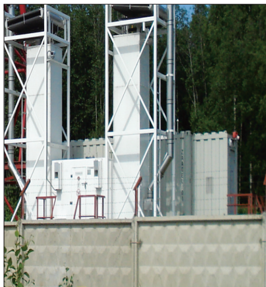
Рис. 7. Схема электроснабжения (слева) и общий вид (справа) блочно-комплектного устройства электроснабжения (БКЭС) с АИЭ: ВРУ – внутреннее распределительное устройство; ДЭУ – дизель-электрическая установка; АБ – аккумуляторная батарея
