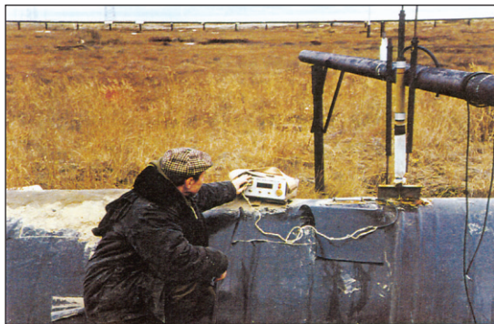
Рис. 3. Измерение силовых параметров взаимодействия газопровода с многолетнемерзлыми грунтами
