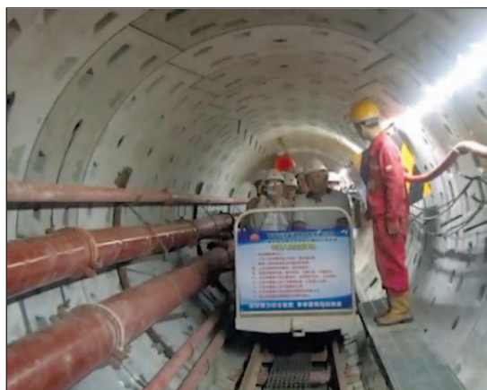
Рис. 6. Тоннельный переход под р. Амур
