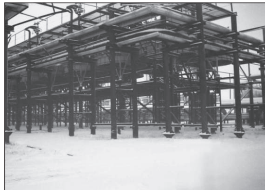
Рис. 4. Внешний вид конденсаторов, установленных на площадке СОГ
