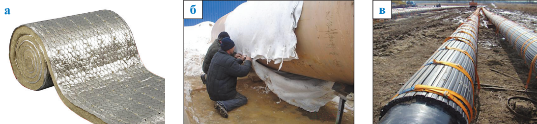
Рис. 1. Разновидности мягких покрытий для защиты трубопроводов от механических воздействий: а – защитный мат; б – скальный лист; в – полимерный профиль (может быть жестким)
