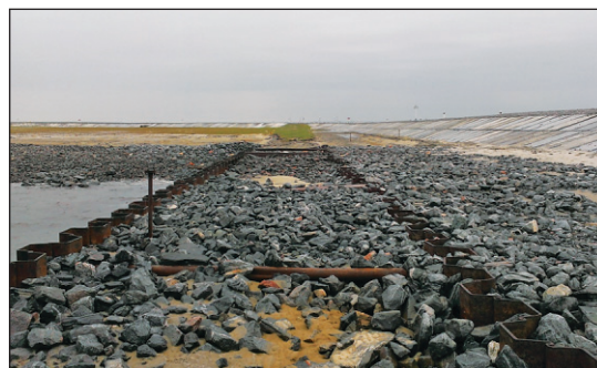
Рис. 3. Береговой участок подводного перехода МГ через Байдарацкую губу, вид на коффердам (ямальский берег Байдарацкой губы)
