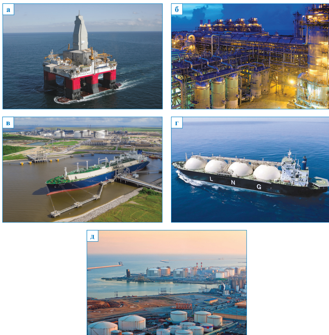
Рис. 1. Технологическая цепочка «производство – потребление СПГ»: а – платформа по добыче природного газа; б – СПГ-завод; в – терминал по хранению и отгрузке в порту; г – транспортировка СПГ-танкером; д – завод по хранению и регазификации в приемном терминале
