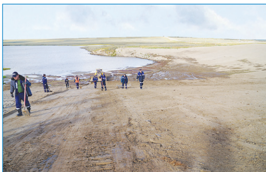
Рис. 17. Укладка биоматов силами ООО «Газпром добыча Надым»
