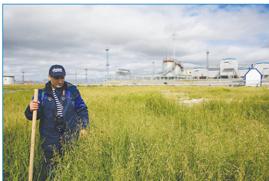
Рис. 3. Северо-западный участок рекультивации разрездов техники у базы бурения
