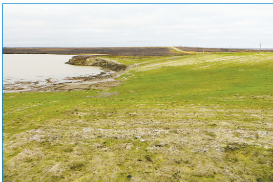
Рис. 18. Рекультивированный участок. Общий вид
