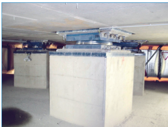
Рис. 2. Установленная скользящая маятниковая опора ИР СПГ, Греция
