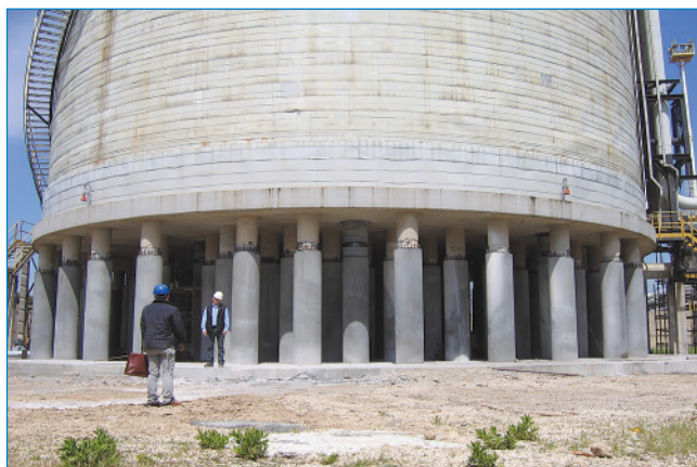
Рис. 3. ИР на скользящих маятниковых опорах для хранения химических реагентов, Италия
