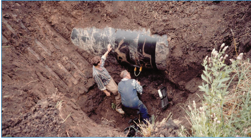
Рис. 6. Обследование в шурфе с помощью прибора УН-5
