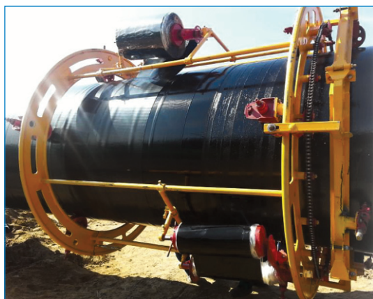
Рис. 9. Нанесение экспериментального защитного покрытия на участке МГ Пунга – Ухта – Грязовец IV с использованием изоляционной машины РИМ-1420
