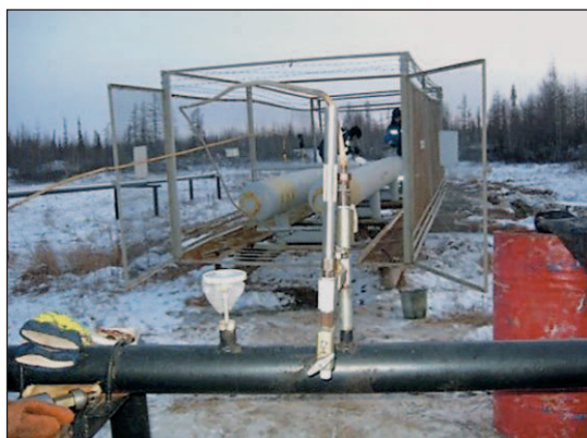
Рис. 3. Испытание и внедрение ПАВ в скважинах месторождений ПАО «Газпром»
