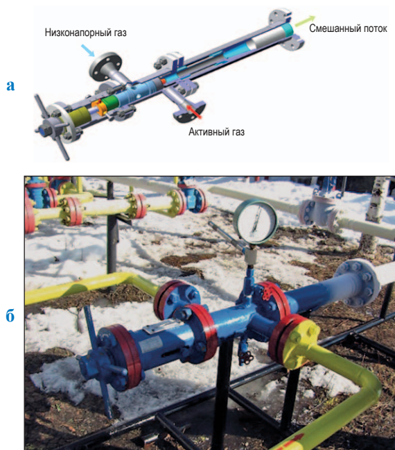
Рис. 2. Регулируемый эжектор для системы сбора и подготовки углеводородов: а – конструирование в формате 3D; б – установка в технологической линии
