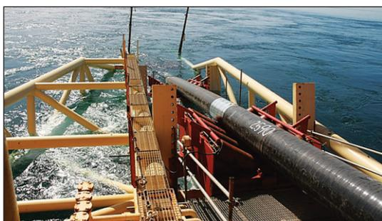
**Рис. 11. Укладка обетонированных труб газопровода Джубга – Лазаревское – Сочи**
