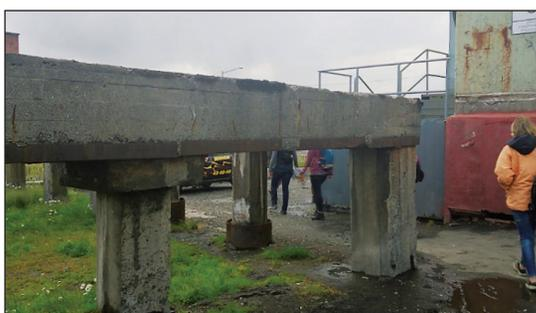
**Рис. 2. Норильск. Фундамент свайного типа на многолетнемерзлых грунтах**
