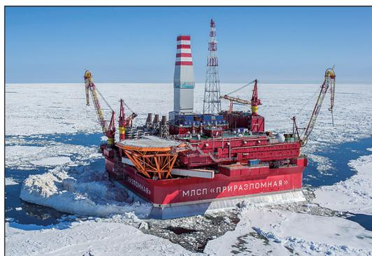
Рис. 10. Стационарная платформа «Приразломная» с кессонным гравитационным основанием
