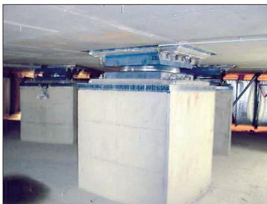
**Рис. 11. Установленная скользящая маятниковая опора ИР СПГ, Греция**
