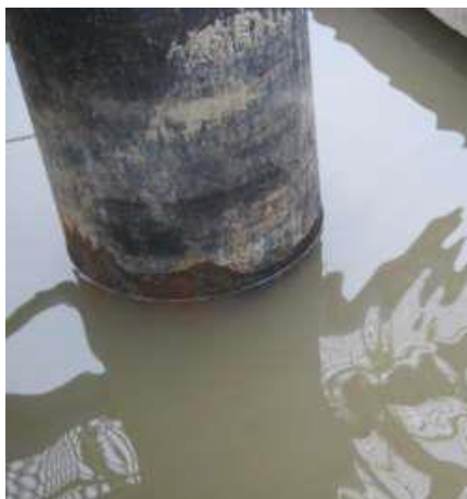
Рисунок 5.1 – Приустьевой провал грунта на скв. №4106 (данные ООО «Газпром ВНИИГАЗ»)
