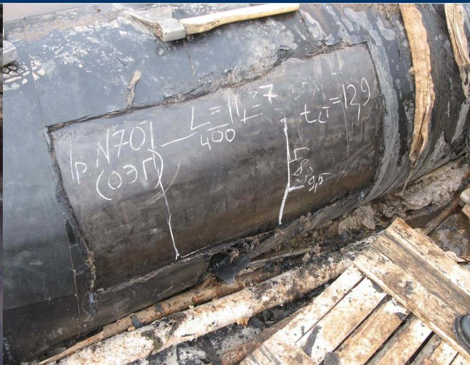
По результатам внутритрубной инспекции на трубах 697 и 701 обследовано 7 зон с наличием заводских дефектов (расслоений с выходом на внутреннюю поверхность). При наружном обследовании дефектов не обнаружено.
