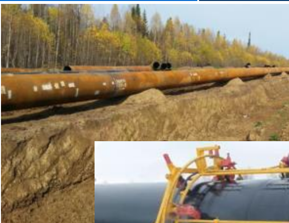
Процесс нанесения изоляционного покрытия с помощью машины (РИМ 1420)
