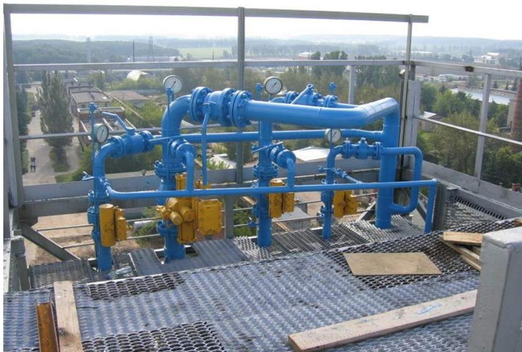
Рисунок 2.18 – 10-й этаж стенда. В желтом цвете – блоки пневматических клапанов-отсекателей
