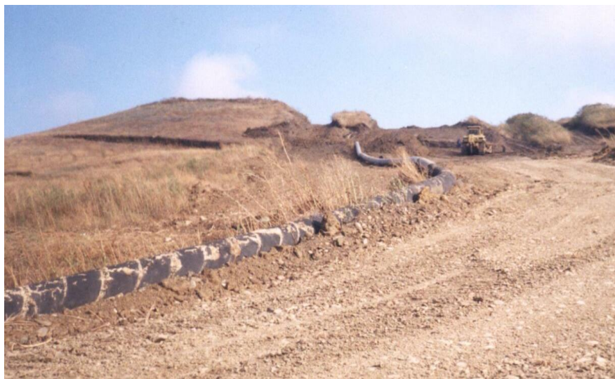
Рисунок 3.6 - Внешний вид нитки газопровода Курсавка-Усть-Джегута
