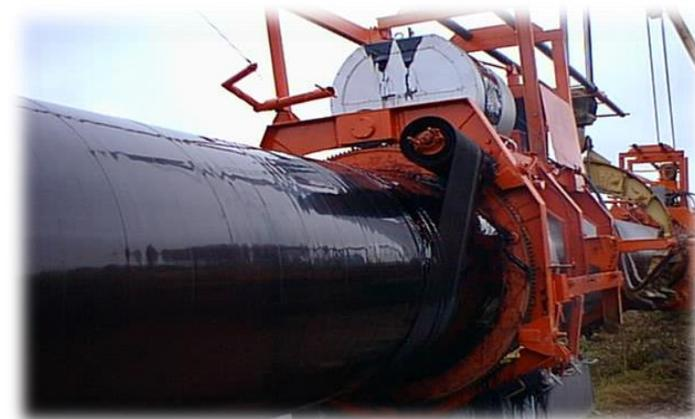
Для трубопровода диаметром 1420 x 18,7 мм (сталь X70)
