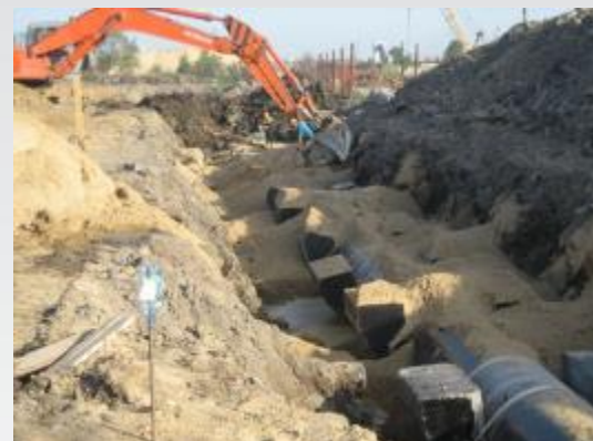
Укладка газопровода
