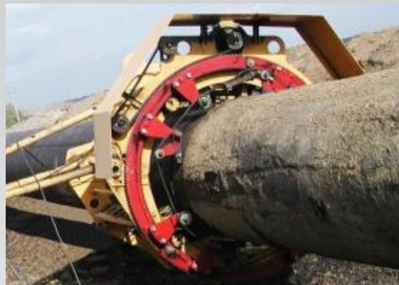
Снятие старой изоляции
