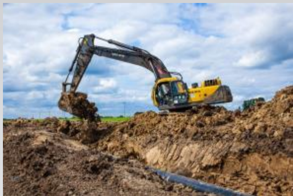
Вскрытие газопровода
