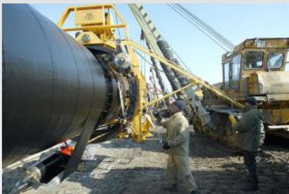
Нанесение новой изоляции
