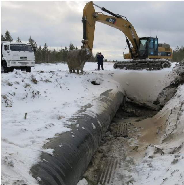
Общий вид шурфа
