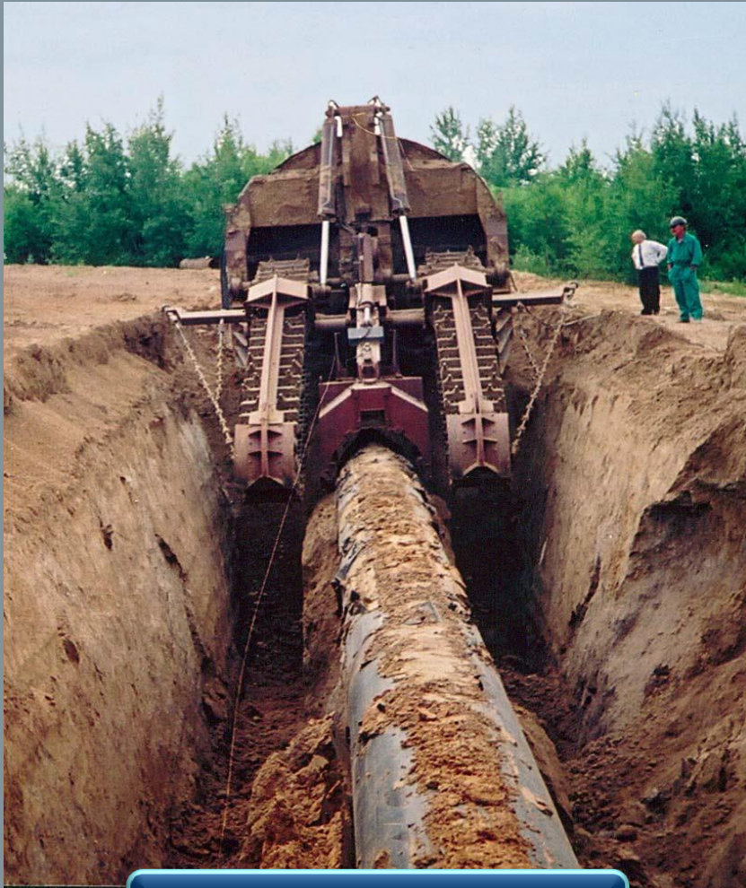
Машина для вскрытия МВТ. (Рис. 3)
