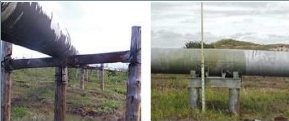
Свободноподвижная и мертвая опоры (Рис. 11, 12)
