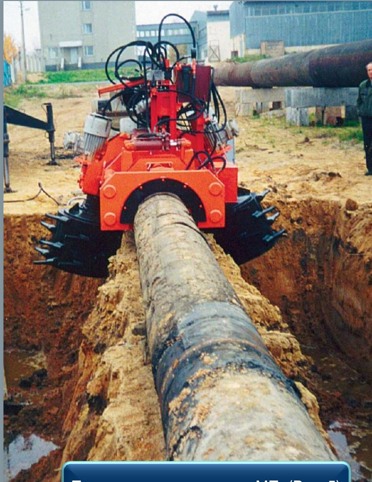
Подкапывающая машина МП. (Рис. 5)
