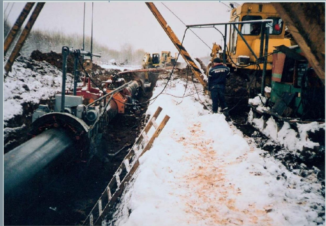
Роторная очистная машина ОМ-12203. (Рис. 6)
