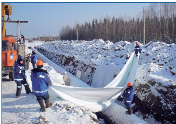
Микуньское АПУМГ, газопровод Ухта – Торжок-2. Балластировка ремонтируемого участка магистрального газопровода с использованием нетканого синтетического материала (2009 г.)
