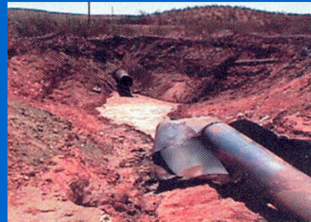
Последствия разрыва трубопровода
