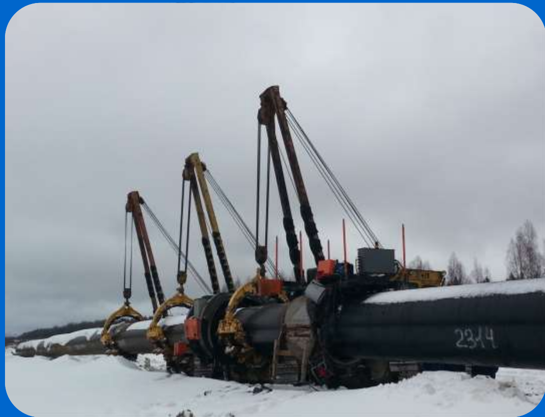
Работы по подготовке участка к нанесению экспериментального покрытия
