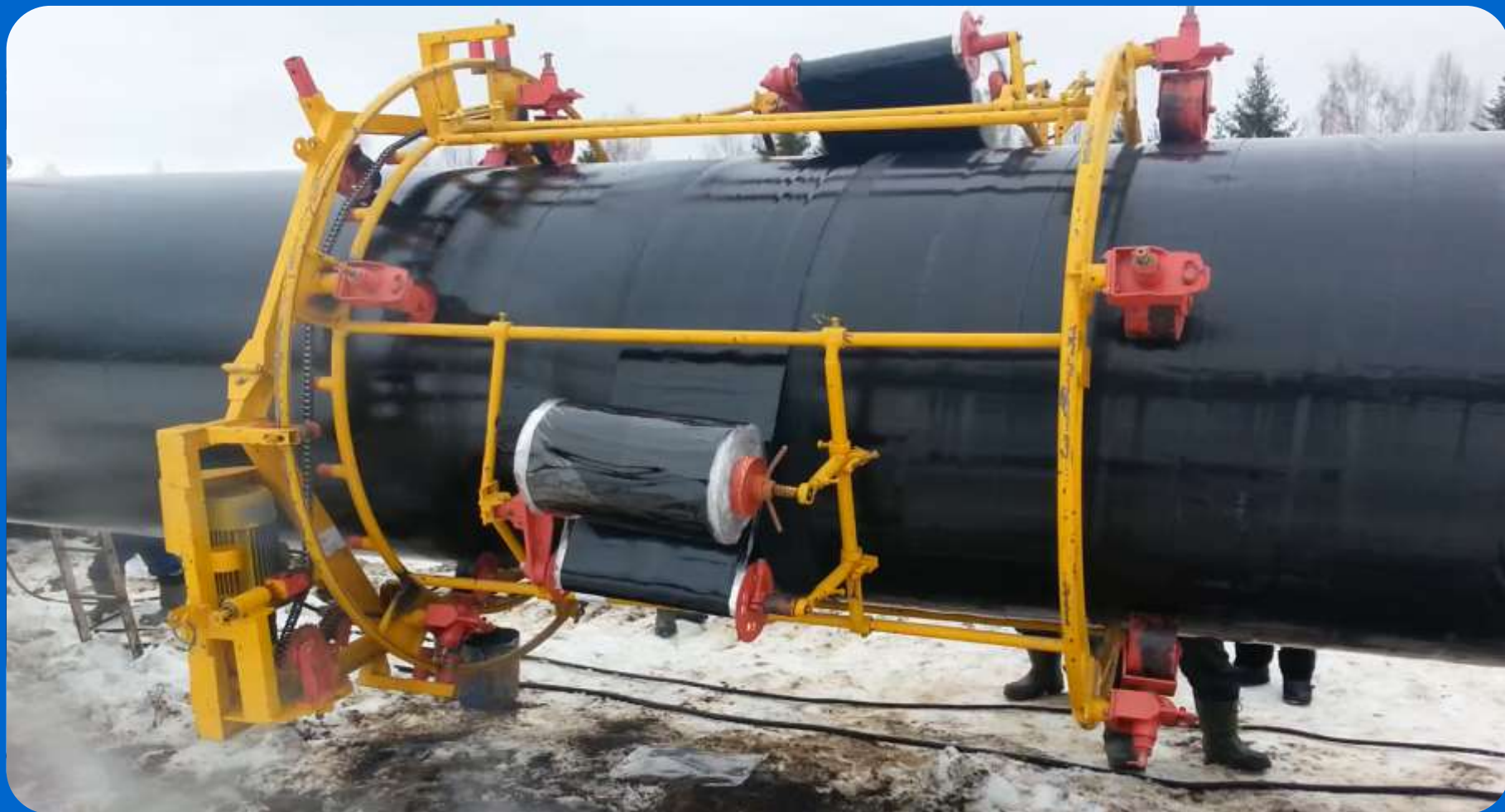
Работы по нанесению экспериментального покрытия
