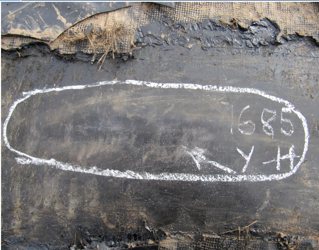
Дефект КРН на трубе №1685 из МГ «Уренгой-Новопсков», к которому грунтовой электролит после переизоляции не поступал
