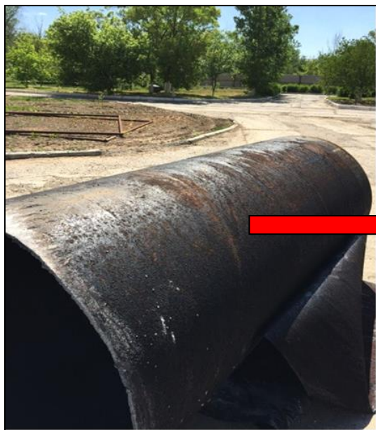
Фрагмент трубы с трещиноподобными дефектами
